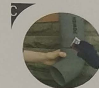
Haluskan ujung pipa dengan amplas
