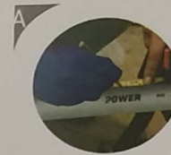
Ukur kedalaman socket dan beri tanda dengan spidol
