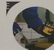
Oleskan lem PVC VIPLAS secukupnya pada permukaan pipa dan Fitting
