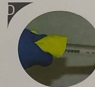
Bersihkan kotoran pada permukaan pipa dan Fitting
