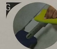
Bersihkan sisa lem PVC VIPLAS pada permukaan pipa dan Fitting
